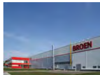
Производственный комплекс BROEN в Коломне
